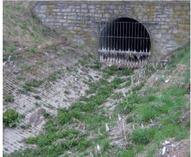
Oestetiska föremål som utmatats vid kraftiga regn, typiska för bräddningsutmatning utan kvarhållande av grövre material
