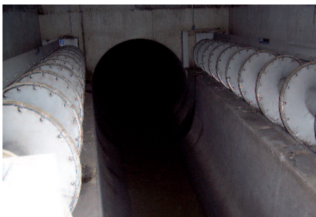
ROTAMAT® RoK 1 silar installerade vid en vinkel på 60° på båda sidor av en bräddningskanal
