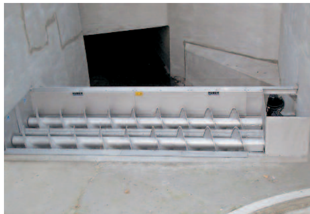
Kombinering av två HUBER ROTAMAT® RoK 1 silar för omhändertagande av mycket höga vattenflöden
