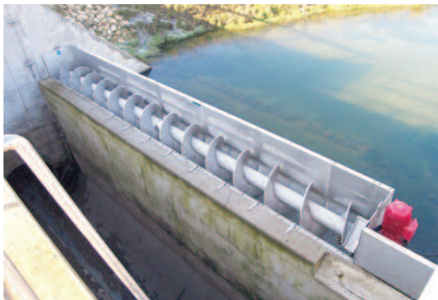
ROTAMAT® Bräddvattensil RoK 1 installerad vid en bräddningsdamm
