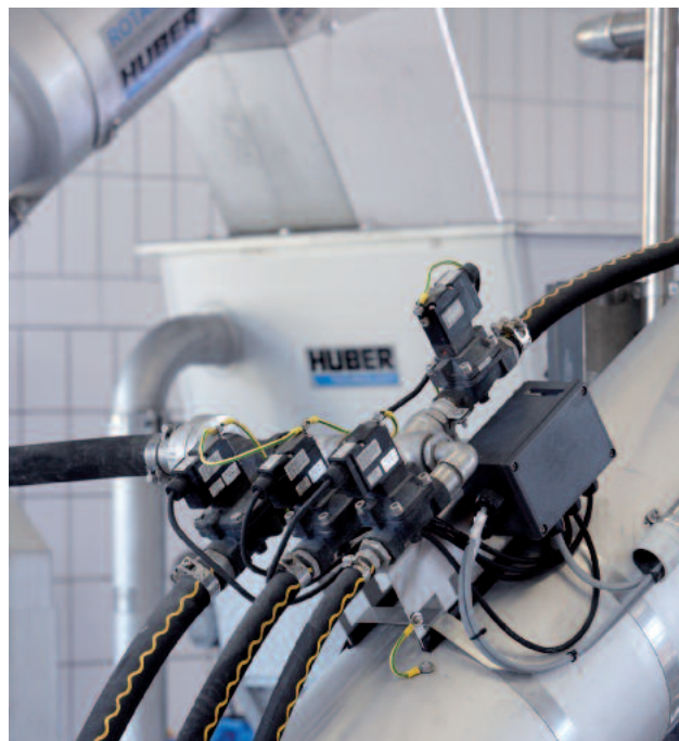
ROTAMAT® siltrumma med integrerad rensodstvätt IRGA
