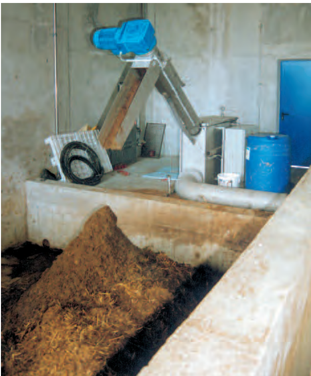
Slakteri Ingolstadt / Tyskland: Överst: ROTAMAT® Skruvsil Ro 9, HUBER Flotationsanläggning HDF-3 med kemiskt behandlingssteg, genomflöde: 30 m 3 /h Vänster: Lastbilsvätt med ROTAMAT® Skruvsil Ro 9 i tank, slutlig TS > 35 %
