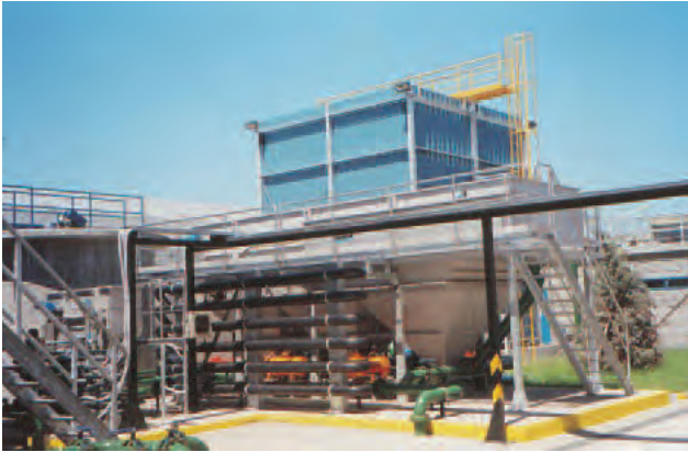
PEPSICO / Argentina: livsmedelsbehandling, ROTAMAT® Skruvsil Ro 9, HUBER Flotationsanläggning HDF-75 med kemiskt behandlingssteg, genomflöde: 70-80 m 3 /h
