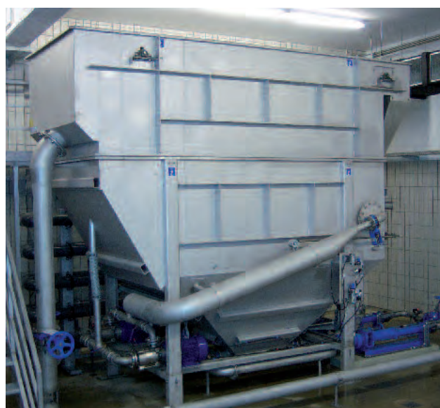
Hans Kupfer & Sohn GmbH Co. / Tyskland: HUBER Flotationsanläggning HDF-10 med kemiskt behandlingssteg, genomflöde: 100 m 3 /h
