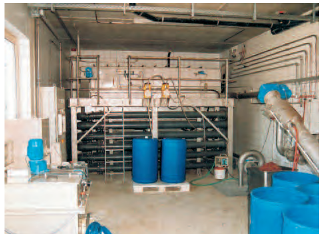
Slakteri Ingolstadt / Tyskland: Överst: ROTAMAT® Skruvsil Ro 9, HUBER Flotationsanläggning HDF-3 med kemiskt behandlingssteg, genomflöde: 30 m 3 /h Vänster: Lastbilsvätt med ROTAMAT® Skruvsil Ro 9 i tank, slutlig TS > 35 %
