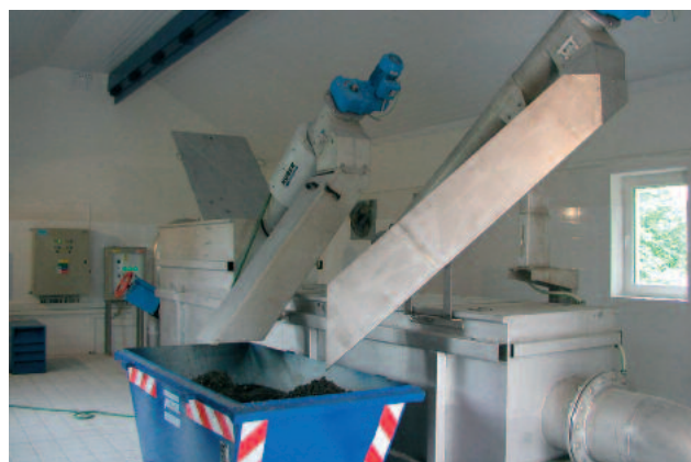
ROTAMAT® kompaktanläggning Ro 5K med integrerad korsströmsavskiljare
