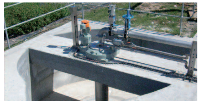
Installation av HUBER VORMAX före uppstart
