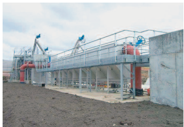
Installation ovan mark av ett ROTAMAT® långsandfång Ro 6 med föregående silning
