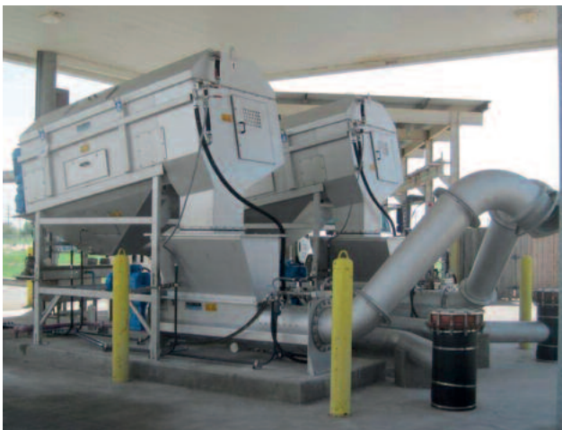
ROTAMAT® Tvättrumma för tvättning och avskiljning av grova material > 10 mm
