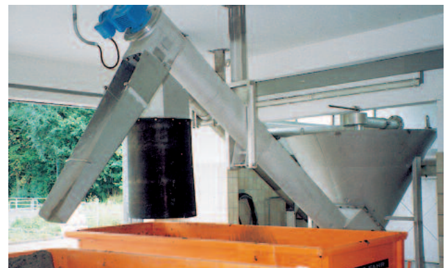
En avskiljningsskruv transporterar sanden från avskiljningsbehållaren in i en ränna.
