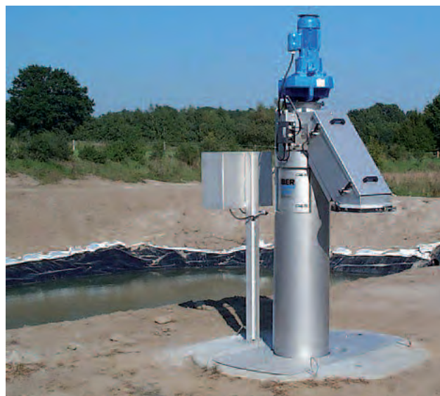
Installation uppströms en dammanläggning
