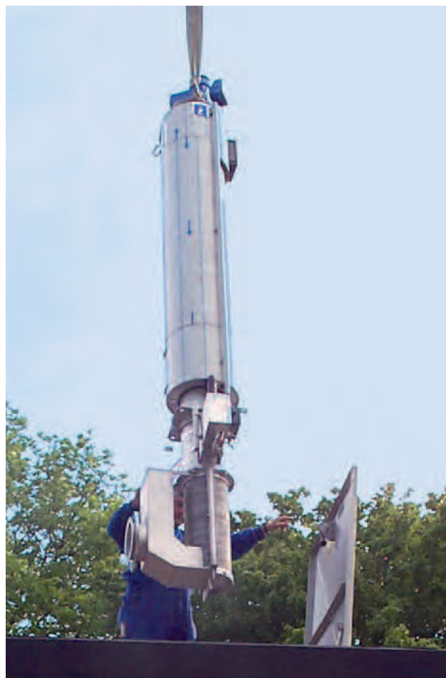
ROTAMAT® vertikal silanläggning RoK 4 lyfts in i en pumpstation
