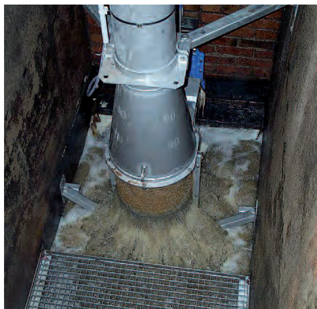
ROTAMAT® Vertikal silanläggning RoK 4 i drift
