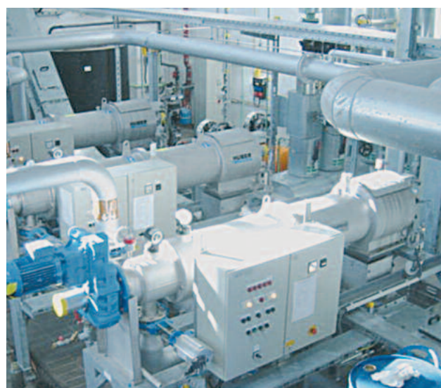
Silning av rötslam (industri)
