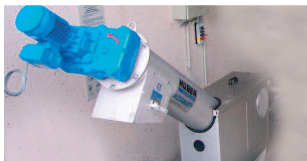
Tankmonterad ROTAMAT® Skruvsil Ro 9Ec
