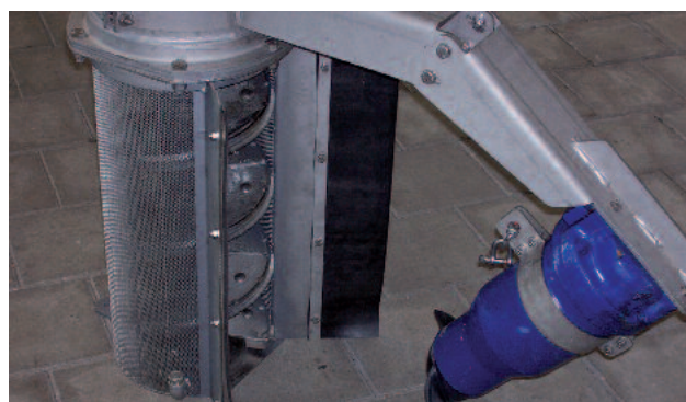
Extern rensodstvävtsystem (ERGA). Ett föregående tvättssystem tvättar bort de organiska partiklarna.
