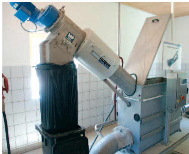
Tankinstallation av en ROTAMAT® Skruvsil
