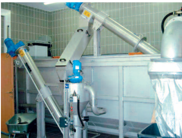
Avskiljningsskruv med efterföljande HUBER sandtvätt RoSF 4/tC
