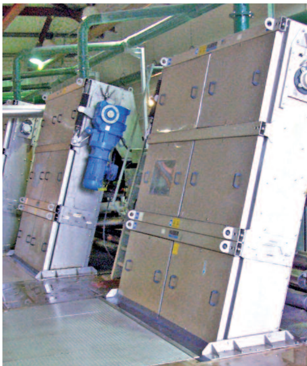
Universellt passande HUBER RakeMax®-sil för stora kanalvidder...
